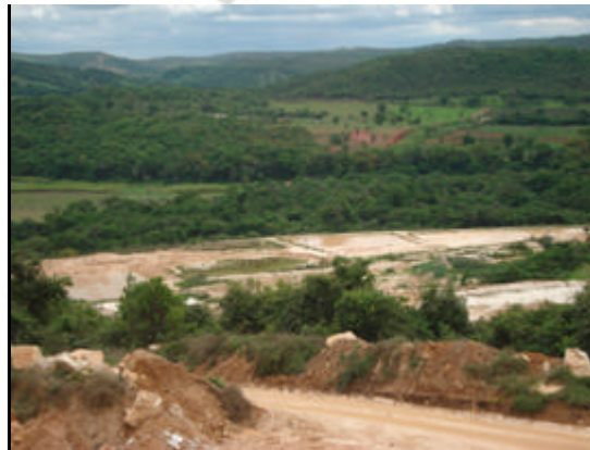
Foto 16. Bacia de decantação.
