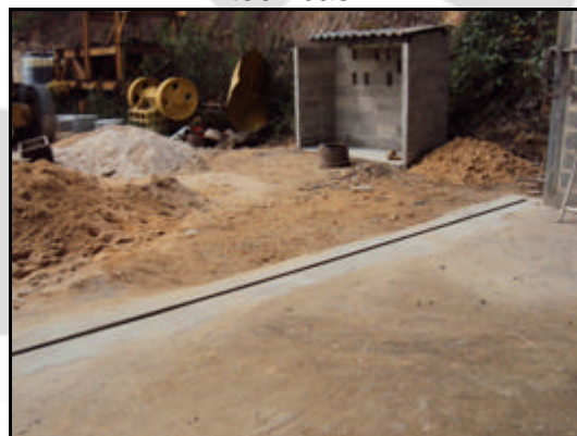
Foto 12. Implantação de canaleta para a caixa separadora de água e óleo na oficina.
