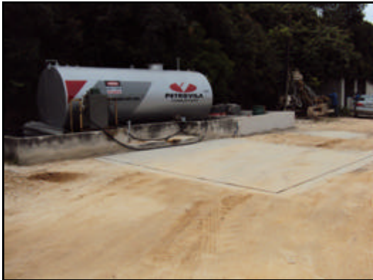
Foto 07. Pista de abastecimento de concreto.
