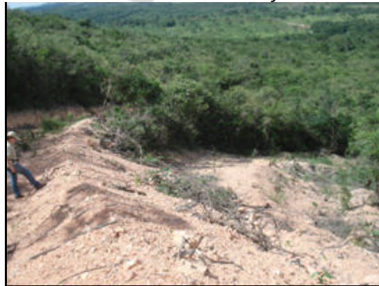
Foto 04. Retirada de solo da estrada e soterramento de uma pequena faixa da mata local.
