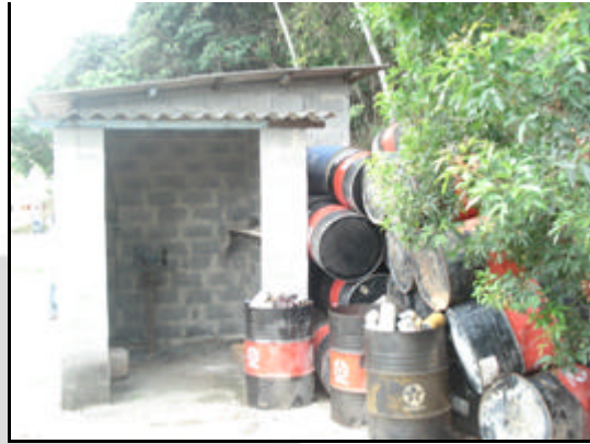
Foto 20. Acondicionamento inadequado de resíduos oleosos.
