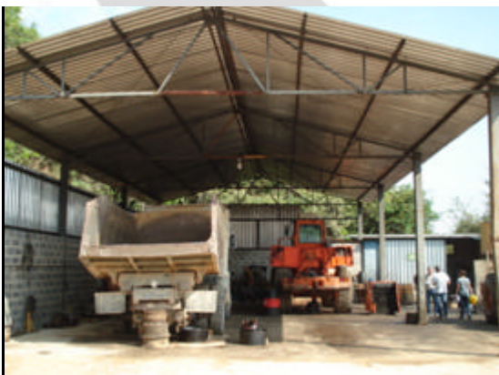
Foto 11. Oficina com piso impermeável, mas sem canaleta para a caixa separadora de água e óleo.
