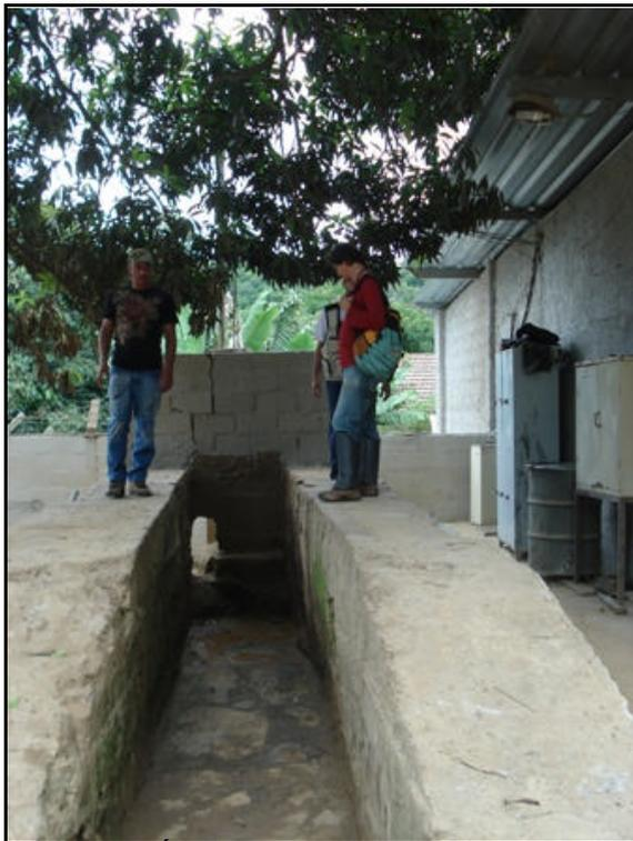
**Foto 11.** Área, destinada à manutenção de máquinas com mureta fissurada e quebrada, à montante da caixa separadora.
