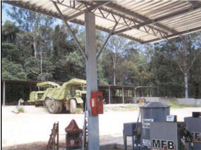
**Foto 13.** Estrutura do posto de abastecimento (após adequações nos pilares e fiação elétrica).
