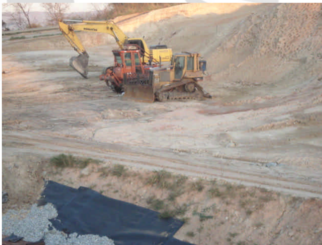
Foto 11: Trator e escavadeira na área do Aterro 02
