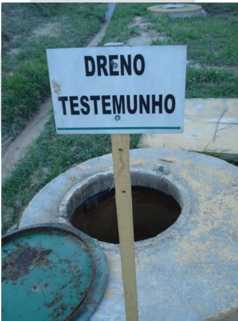
Foto 01: Dreno testemunho para monitoramento de vazamentos do Aterro 01
