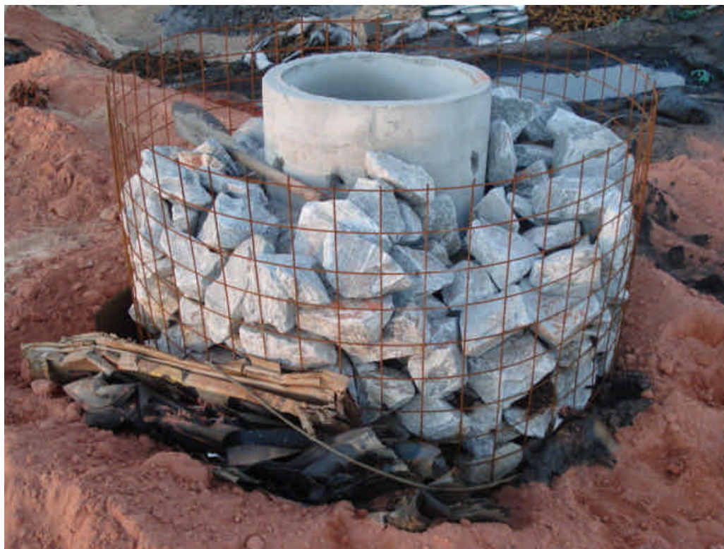
Foto 10: Coluna do sistema de drenagem de gases do Aterro 02
