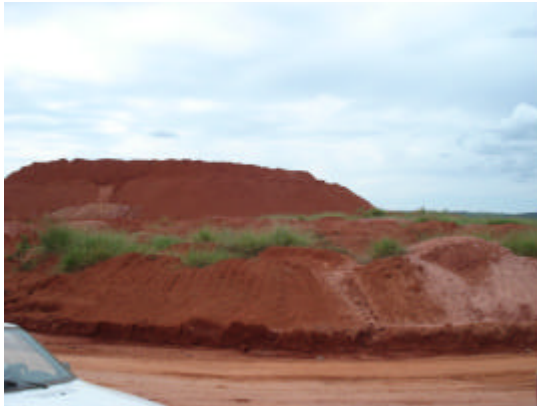
Foto 07. Estoque de solo vegetação sobre a pilha a ser usado na sua recuperação.
