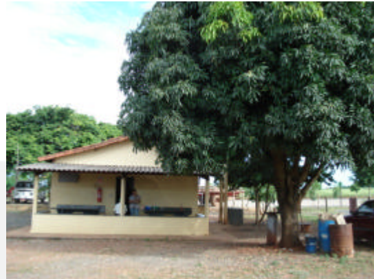
Foto 08. Vista das instalações dos empregados (dormitório, sanitário e cozinha).
