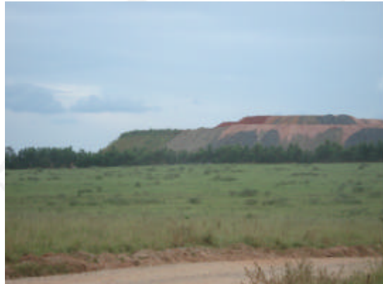
Foto 04. Detalhe da pilha em construção (todas as fases) e com cortina arbórea na base.
