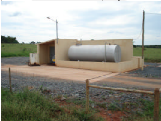
Foto 09. Vista do tanque aéreo e respectiva bomba de abastecimento.
