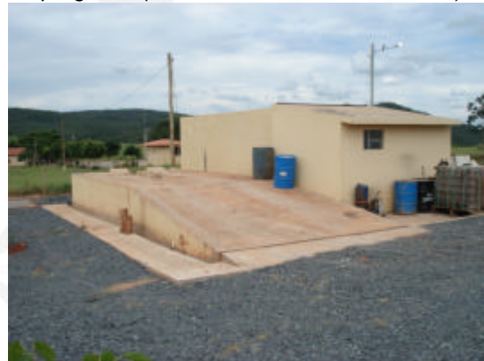
Foto 10. Vista da estrutura de lavagem e manutenção de equipamentos.
