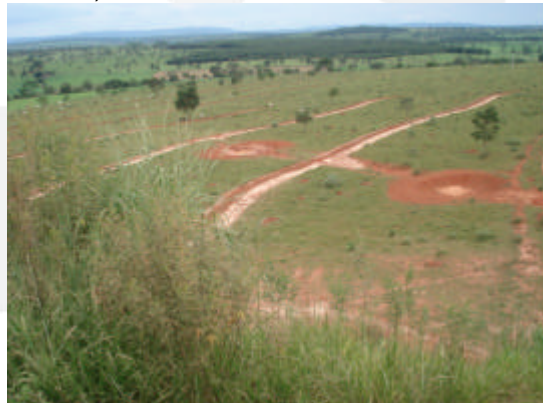
Foto 06. Utilização de terraços em nível em torno da pilha para drenagem no solo das águas superficiais.
