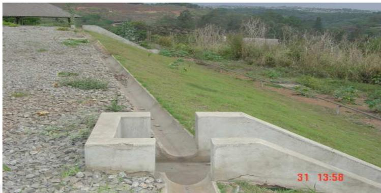
Figura 02 – Canaletas e escada desaguadora de águas pluviais
