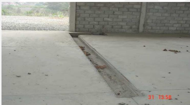
Figura 01 – Canaleta de concreto ligada a caixa de decantação
