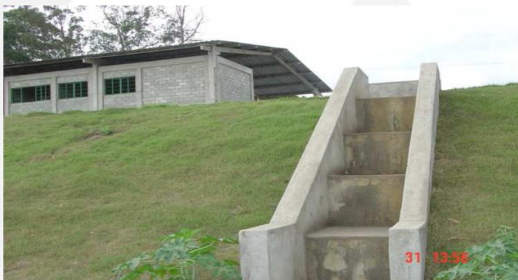
Figura 03 – Taludes revegetados
