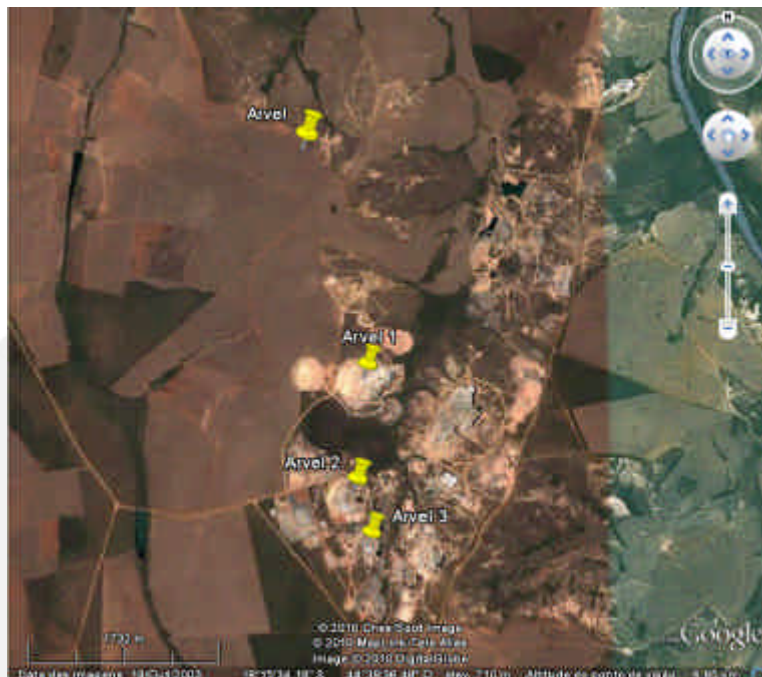
Imagem 01. Vista área do empreendimento e área de entorno. Fonte: Google Earth – Maio de 2010.
