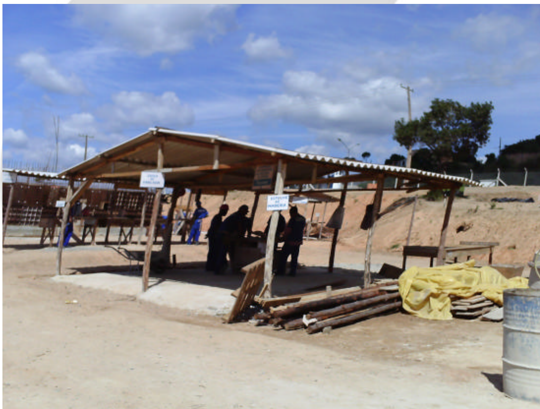
Foto 01: Galpão do canteiro de obras da ETE Veneza
