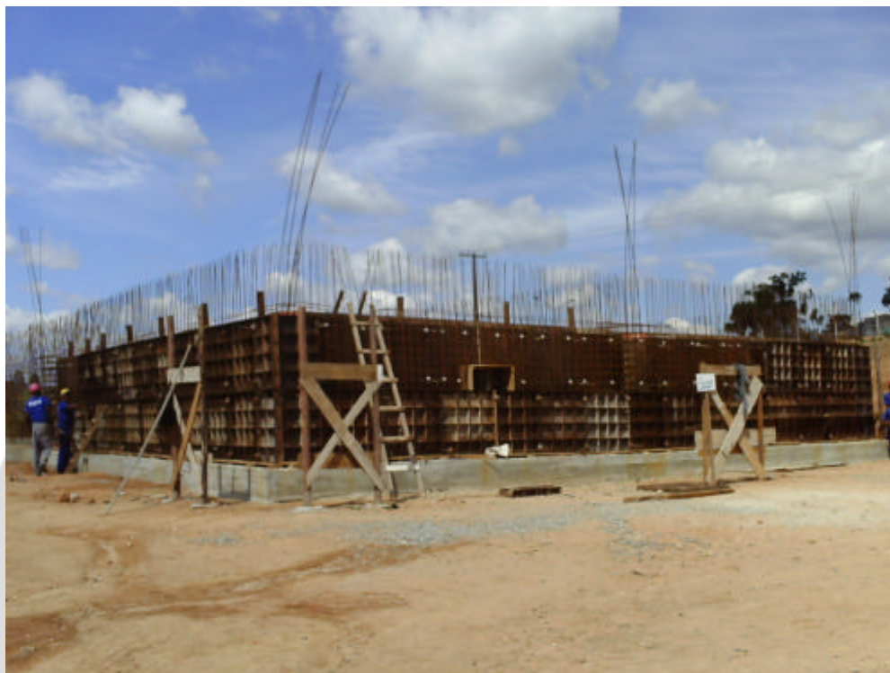
Foto 02: Reator Anaeróbio da 1ª etapa da ETE Veneza (em implantação)
