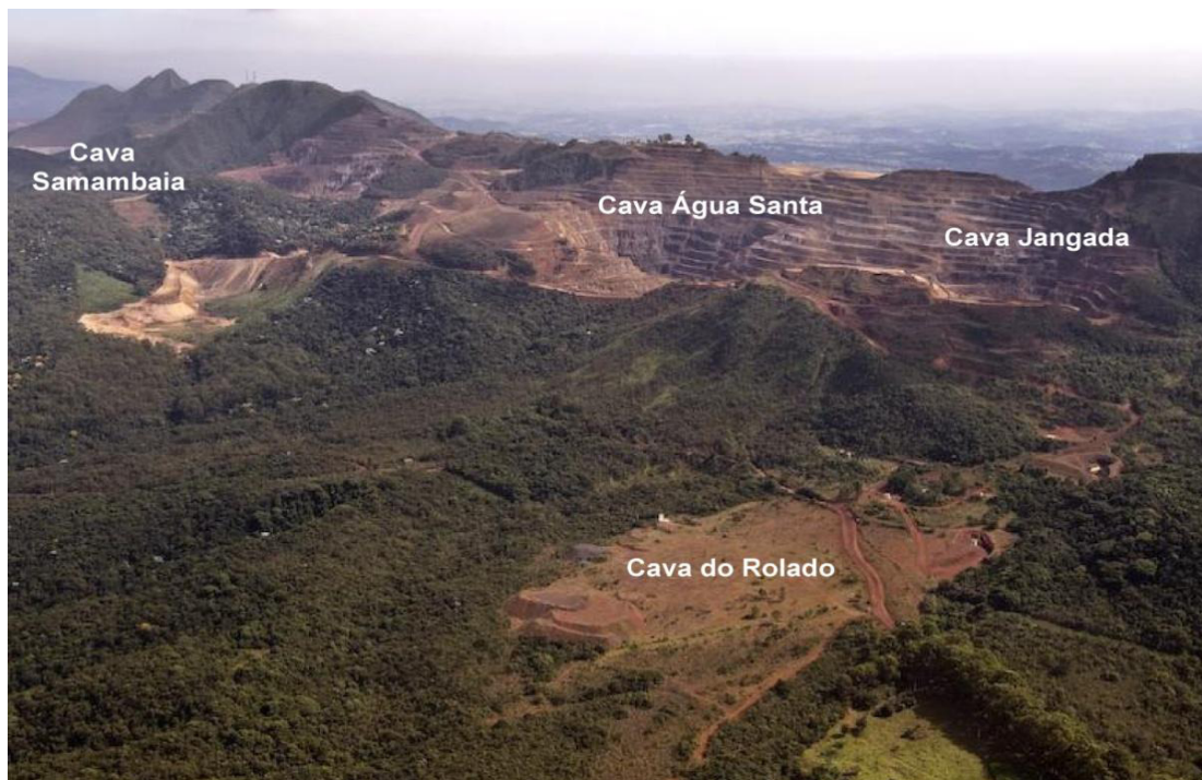
avas em Operação e Implantação na Mina da Jangada-Fonte: Vale , 2008
