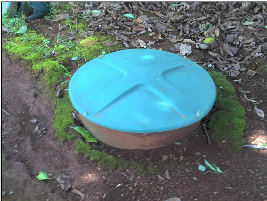
Foto 03: Vista da fossa séptica
