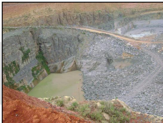
**Foto 2:** Vista do SUMP para armazenamento de água pluvial dentro da cava.
