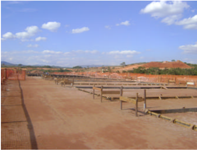
Foto 10: Construção das fundações das futuras moradias
