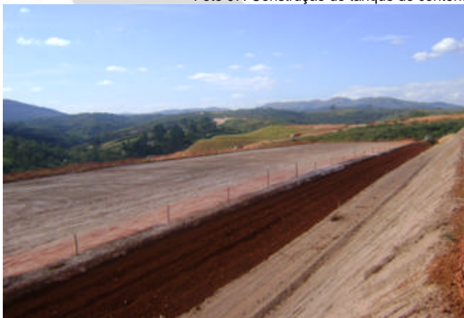
Foto 08: Construção do arruamento do novo bairro que irá receber às famílias assentadas provenientes do bairro Plataforma
