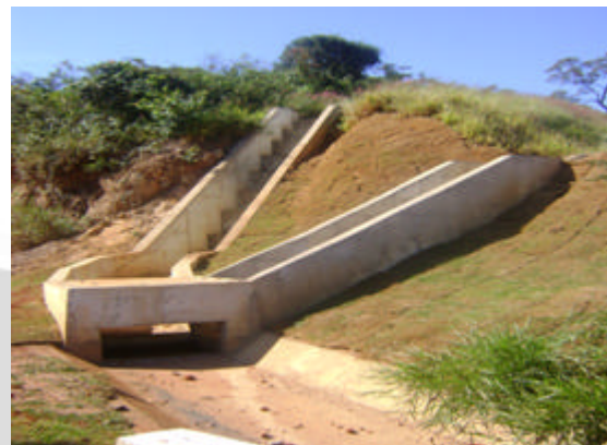
Foto 06: Dissipador de energia
