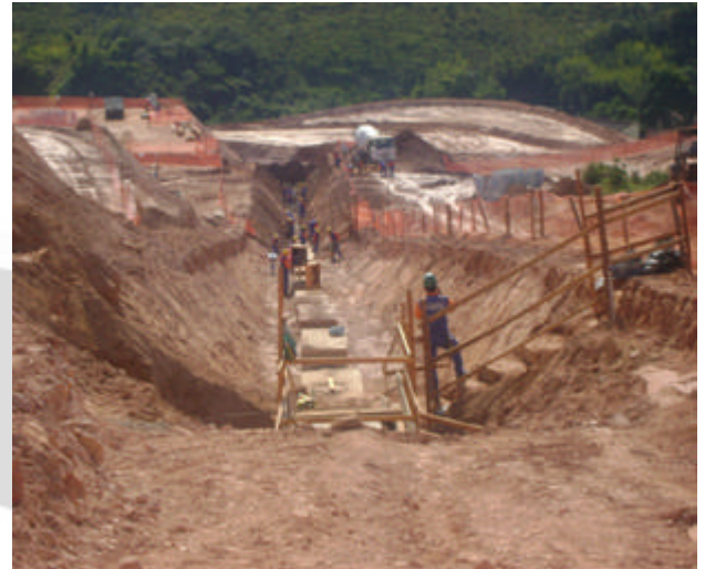
Foto 11: Construção da galeria de drenagem pluvial – principal do novo bairro
