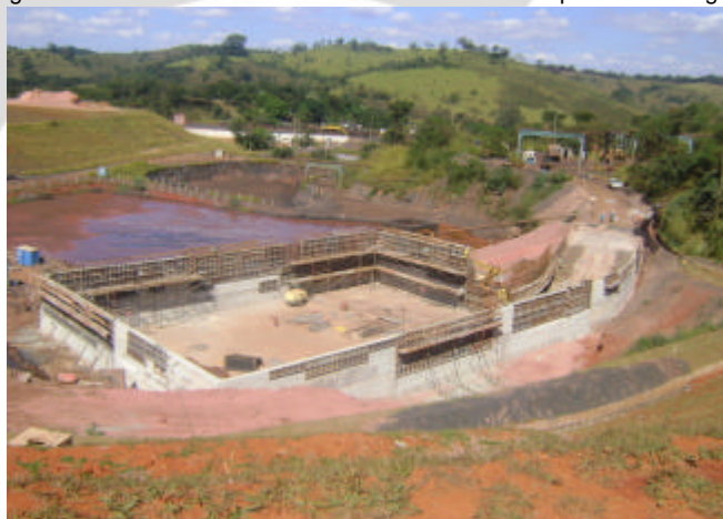
Foto 07: Construção do tanque de contenção e sedimentação de resíduos carreados
