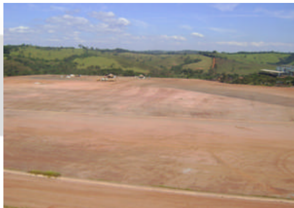
Foto 02: Vista Geral do empreendimento (2) –Área terraplenada
