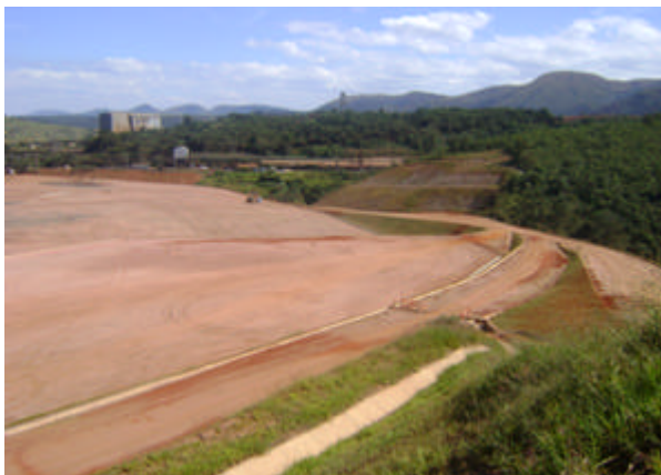
Foto 01: Vista Geral do empreendimento (1) –Área terraplenada
