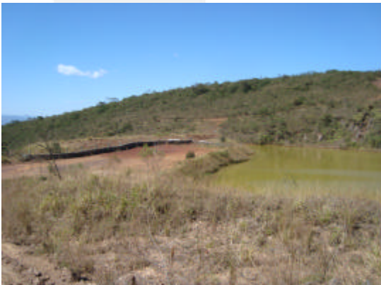
Foto 05. Bacia de contenção de finos (drenagem da mina).
