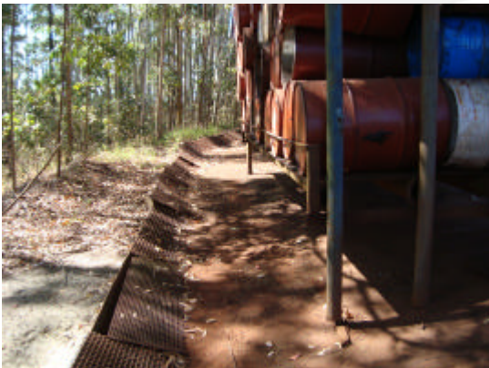
Foto 09. Sistema de drenagem da oficina ligado à caixa separadora de água e óleo (SAO).
