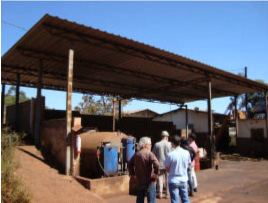
Foto 07. Bacia de contenção do tanque de abastecimento.
