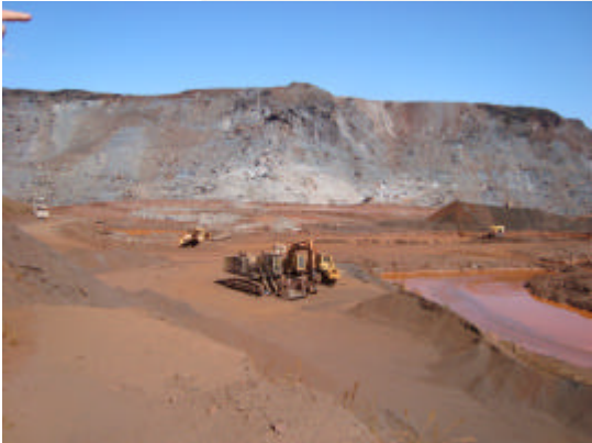
Foto 03. Vista da cava (continuação da foto 02).
