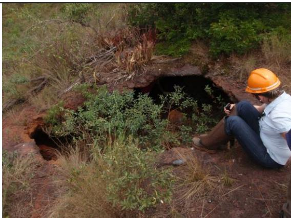
**Figura 22: Vista Geral do colapso acidental que ocorreu na PBR-15.**
