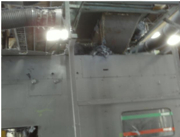
Foto 03. Indicação de que o coletor de pós de fibras não atende a demanda gerada.
