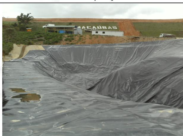
Foto 4 – Expansão do tanque de coleta de chorume, área de aterro ao fundo
