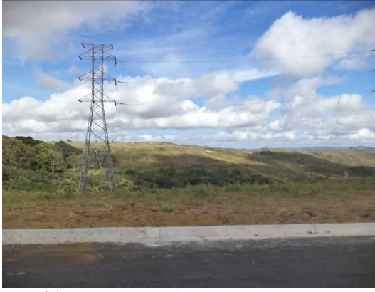
Foto 01 – Subestação de Diamantina
