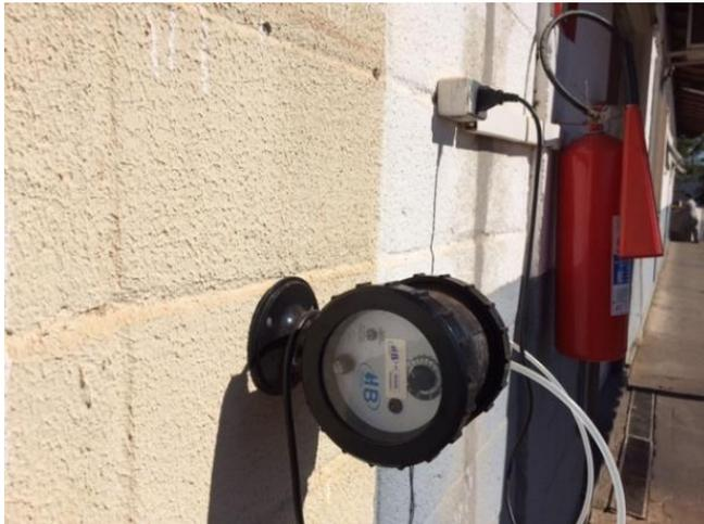
**Foto 3:** Dosador de Bactérias da Estação de Tratamento de Efluentes Sanitários
