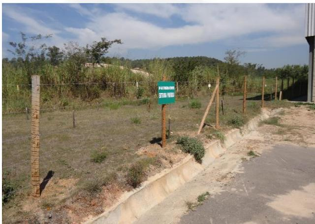
**Foto 03.** Canaletas de drenagem pluvial
