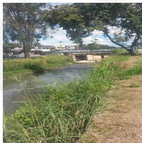
Foto 04. Trecho a ser canalizado
