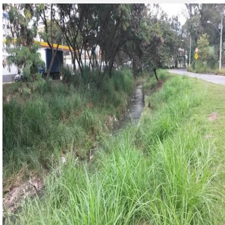
Foto 01. Trecho a ser canalizado
