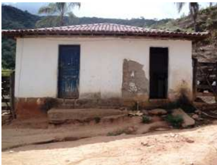
CASA DE QUEIJO / DEPÓSITO
