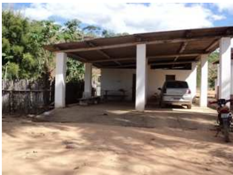
VISTA GARAGEM / GALPÃO
