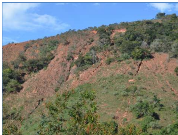
FOTO 6.33: ÁREA COM EROSIÃO LAMINAR E RAVINAMENTO NO ENTORNO DO RESERVATÓRIO DA PCH JACARÉ.
