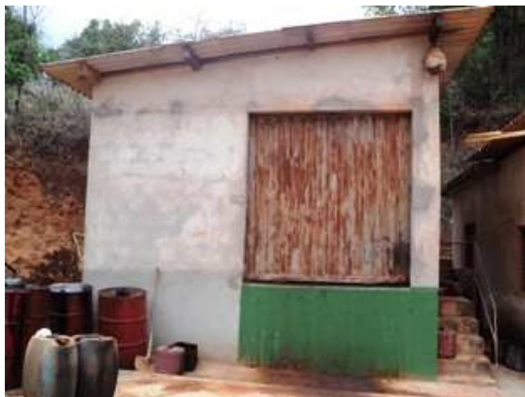
DEPÓSITO DE ÓLEO
