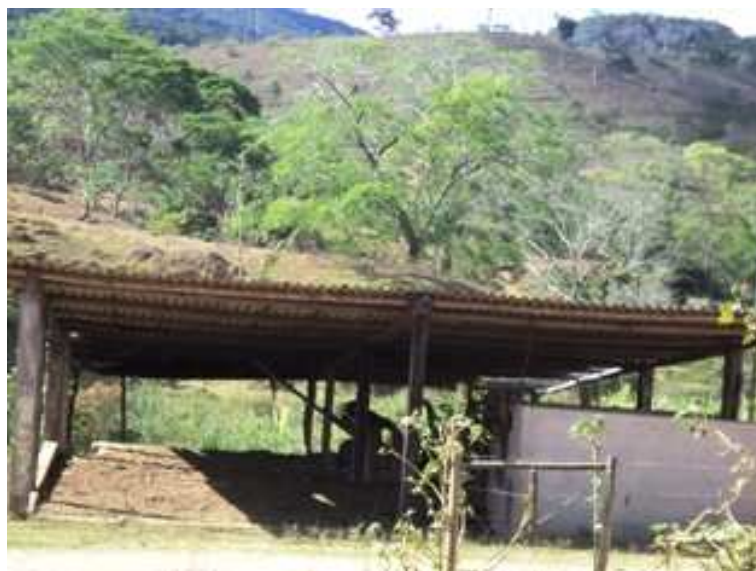
BARRACÃO DE MÁQUINAS
