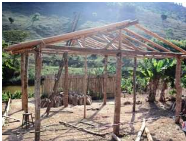
DEPÓSITO EM CONSTRUÇÃO (Posseiro 1)
