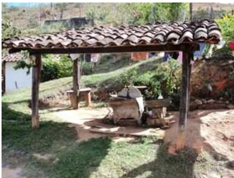
COBERTURA – ÁREA DE SERVIÇO
