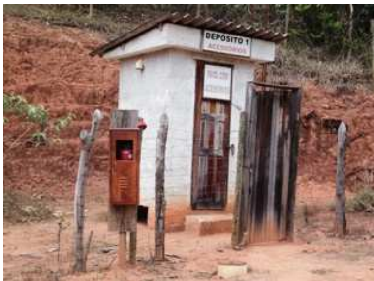
DEPÓSITO DE EXPLOSIVOS I
