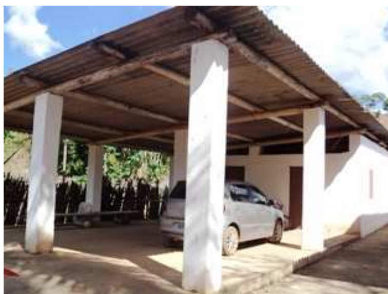
VISTA GARAGEM / GALPÃO
