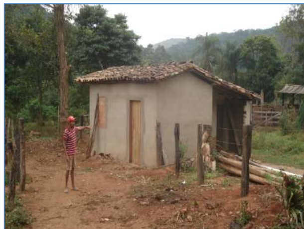
FOTO 6.19 PAIOL QUE FOI REFORMADO
