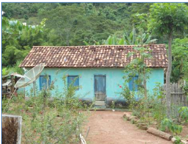
FOTO 6.24 RESIDÊNCIA DO SR. IVAN ISOLINO
