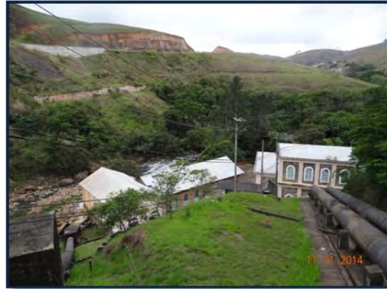
Foto 33 - Vista da casa de máquina e conduto forçado em primeiro plano. Ao fundo mata ciliar em uma estreita faixa confrontando com área de pastagem.
