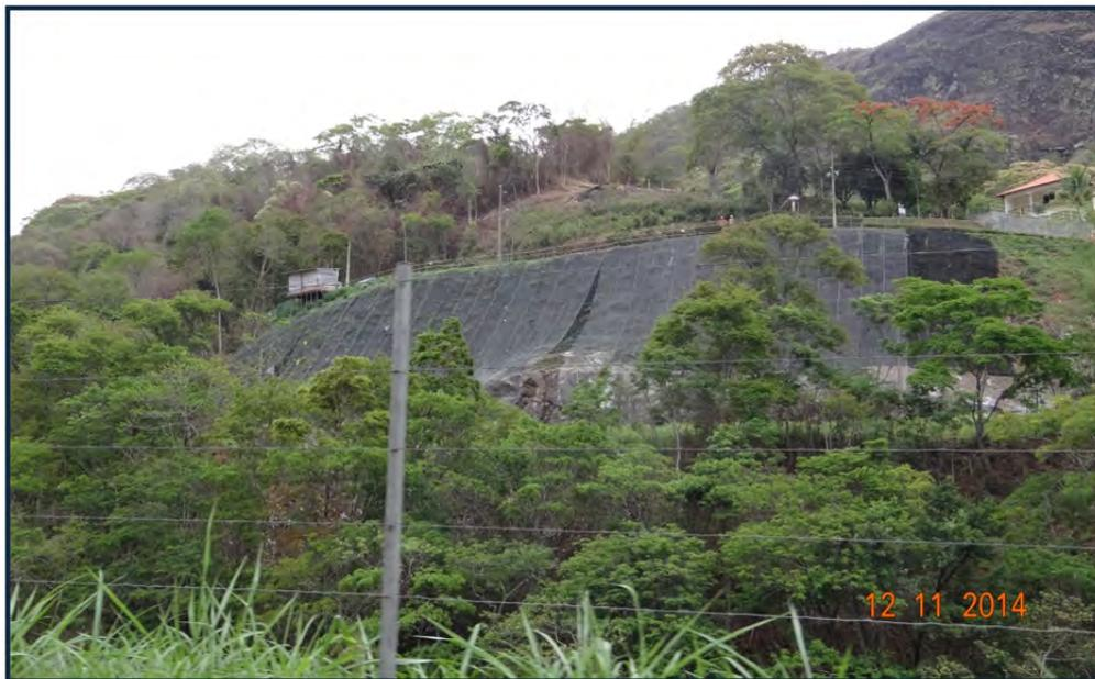
Foto 25 - Revegetação de talude na altura do barramento da PCH Marmelos.
