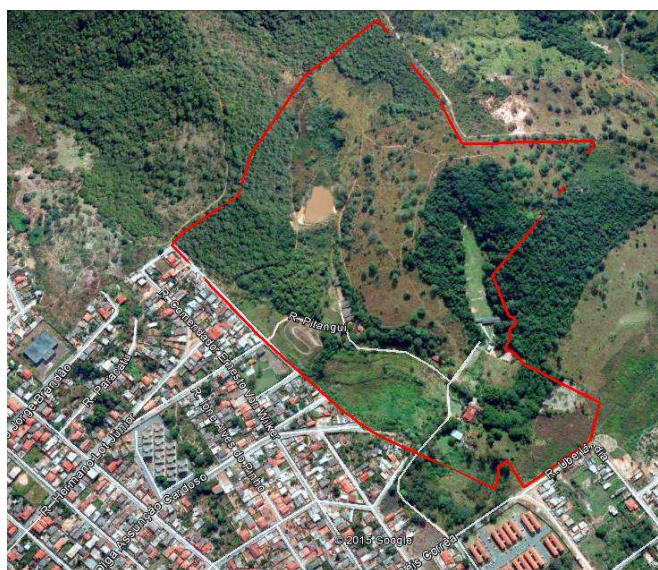
Figura 01. Área do empreendimento.
