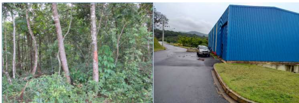
Fotos 1 e 2. Bloco 1 - Área antes da intervenção e após a intervenção.
