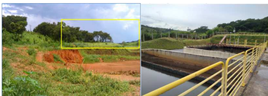
Fotos 3 e 4. Bloco 2 - Área antes da intervenção e após a intervenção.
