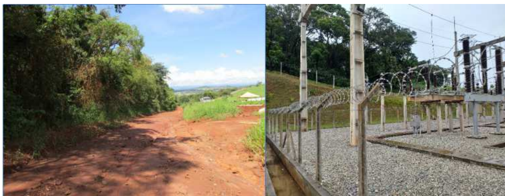
Fotos 5 e 6. Bloco 3 – Área antes da intervenção a após a intervenção.
