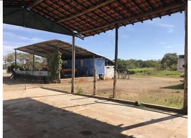
Foto 08: Vista do galpão de manutenção e, ao fundo, oficina mecânica.
