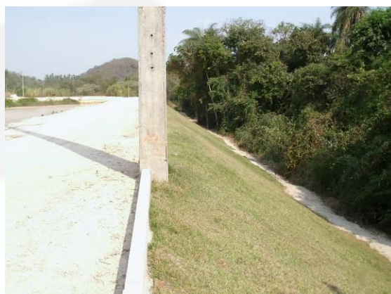
Foto 12. Crista do barramento e talude de jusante com gramínea.
