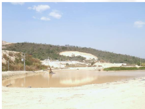
Foto 10. Detalhe de uma das bacias de contenção e recirculação de água do sistema de barramento, próximo à UTM.
