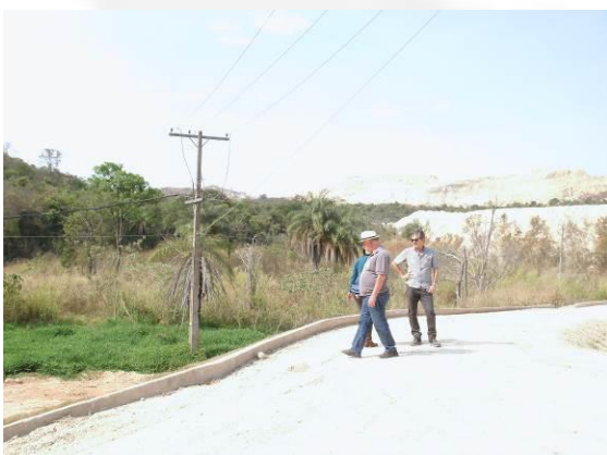
Foto 11. Crista do barramento com sistema de drenagem periférico.
