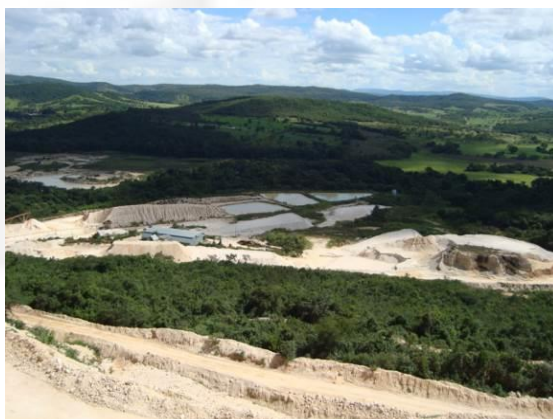
Foto 06. Vista das instalações (UTM, pátios e bacias de decantação).
