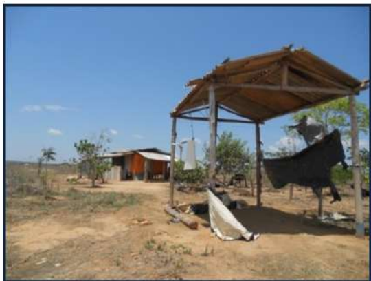
Foto 88 - Edificações na ocupação temporária denominada Ilha
