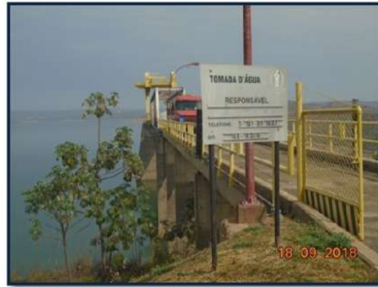
Foto 5 - Vista frontal da tomada d'água
