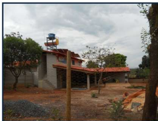
Foto 79 - Pousada sendo construída em Porto Novo
