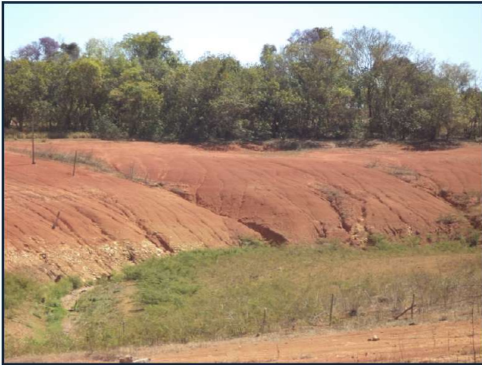
Foto 23 - Sulcos erosivos e ravinações nas margens expostas do reservatório em Felixlândia, ao longo da faixa de deplecionamento
