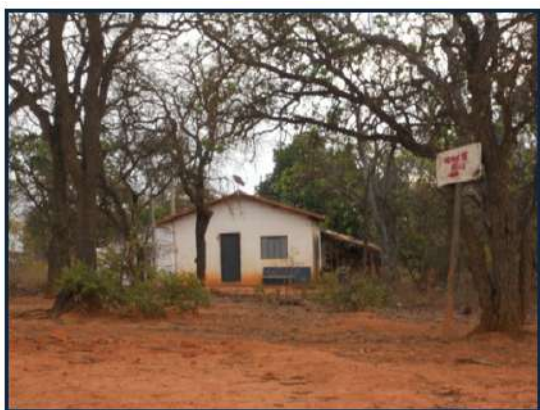
Foto 74 - Edificação no Porto das Melancias
