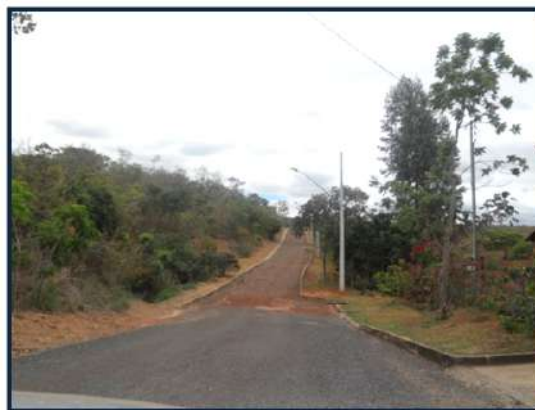
Foto 115 - Arruamento no condomínio Residencial Praia Sul em Três Marias
