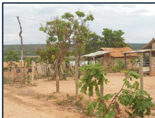
Foto 58 - Edificações em Capão do Açude
