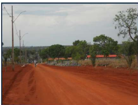
Foto 80 - Implantação de calçamento no cond. Escarpas do Indaiá
