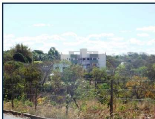
Foto 109 - Edificação de quatro pavimentos no Bairro Parque das Nações
