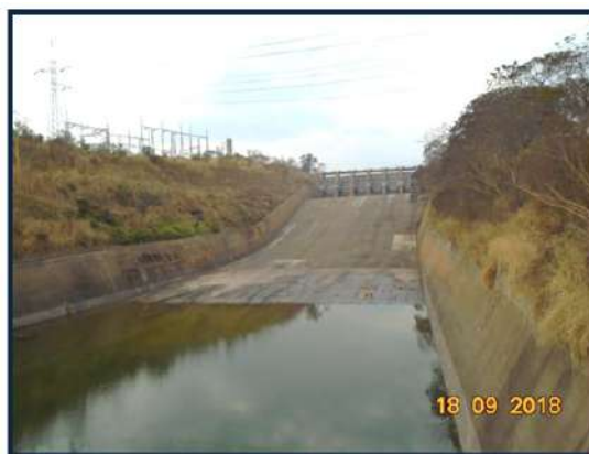
Foto 3 - Vista do vertedouro
