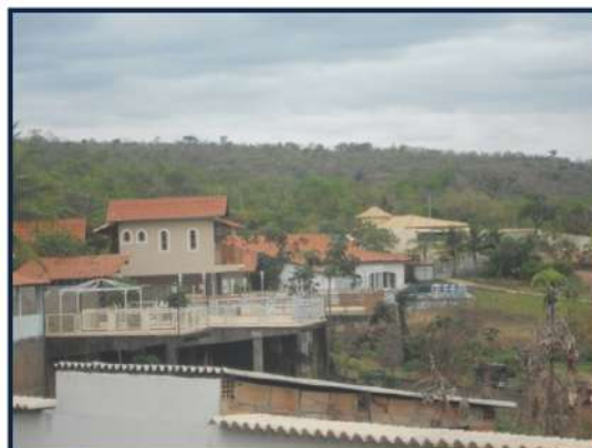
Foto 111 - Edificações no bairro Náutico
