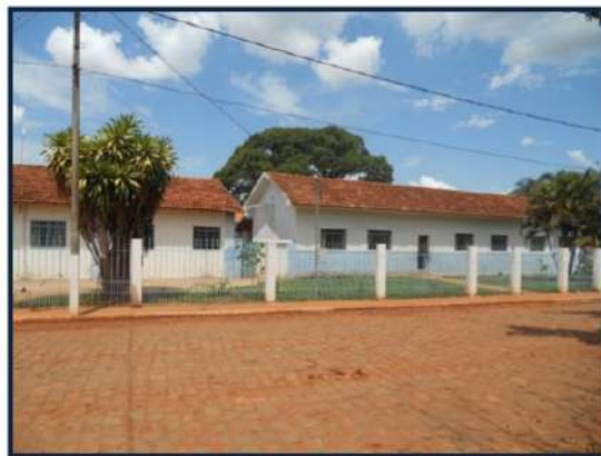
Foto 85 - Escola na comunidade de Vau das Flores
