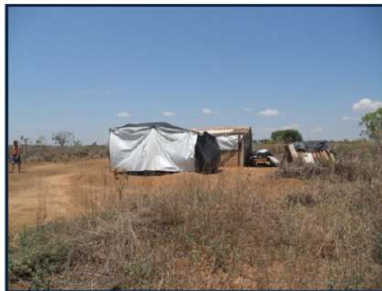
Foto 89 - Edificações de lona na ocupação temporária denominada Ilha
