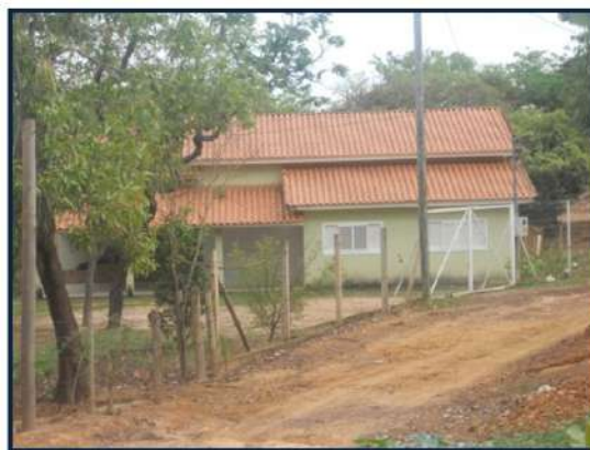
Foto 105 - Edificação no loteamento Pindaíba
