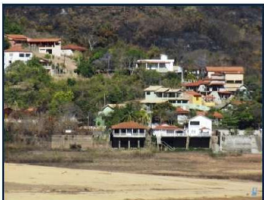
Foto 110 - Edificações construídas, em parte, dentro das águas do lago, no bairro Náutico
