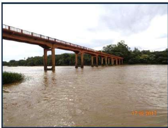
Foto 24- Estação TM10, a montante do reservatório - fev/17
