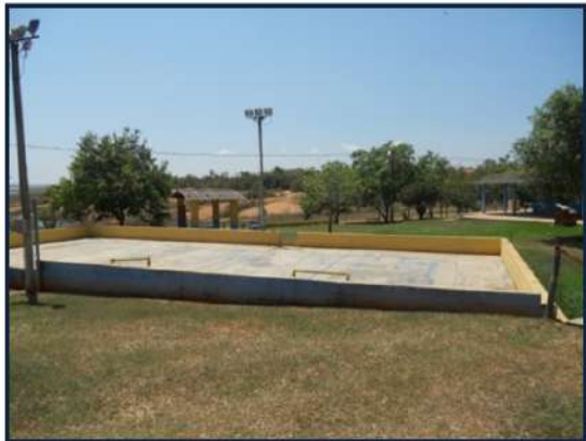
Foto 43- Clube da polícia (ASPRA) com o reservatório ao fundo.
