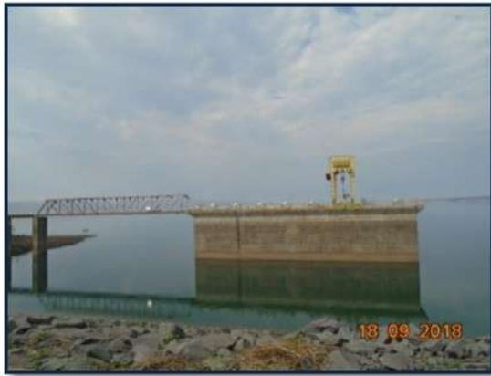
Foto 4 - Vista lateral da tomada d'água
