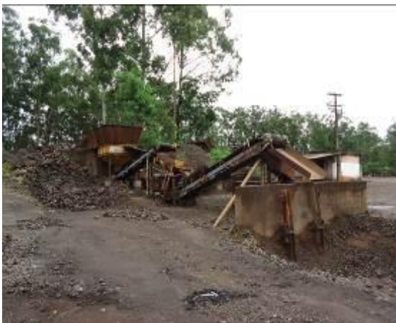
Foto 03. Planta de beneficiamento de escória.
