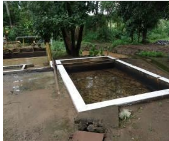
Foto 08. Tanques para recirculação de água e cacimba para águas pluviais.
