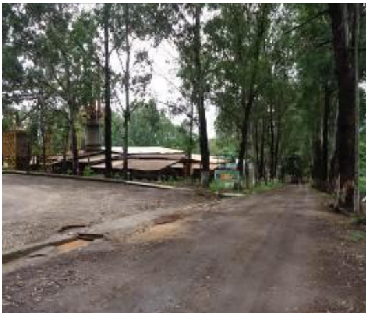
Foto 15. Via interna e canaletas de drenagem pluvial.
