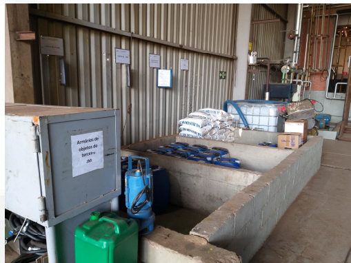
Armazenagem de produtos químicos
