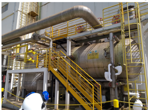
Área externa industrial
