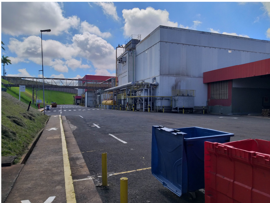
Foto da vistoria, vista da área externa da unidade fabril
