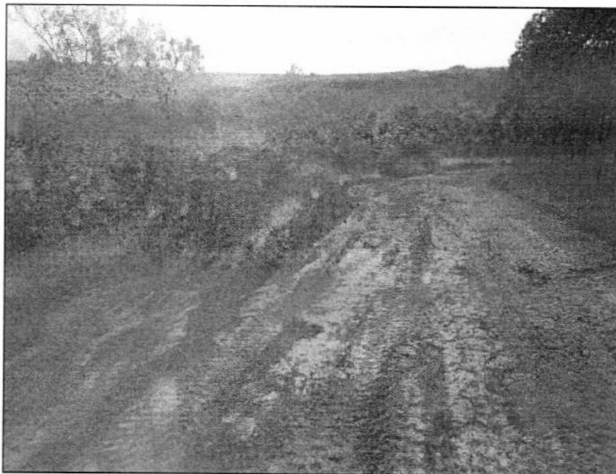
Foto 03: Construção das bacias de contenção próximo do PRAD.
