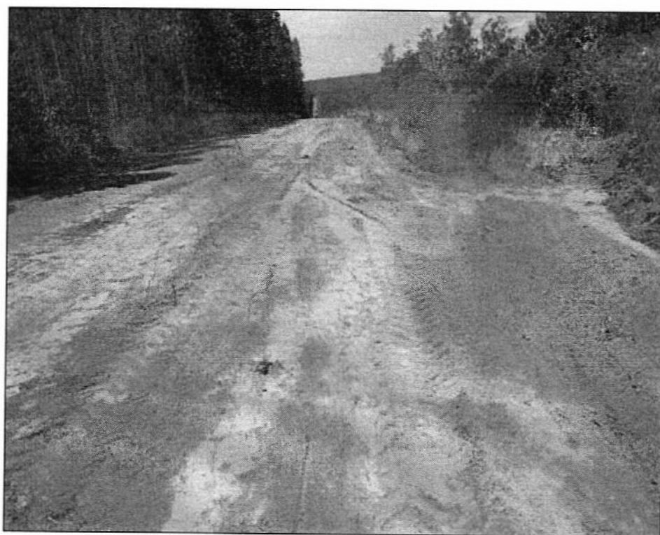
Foto 05: Construção das bacias de contenção próximo do PRAD.
