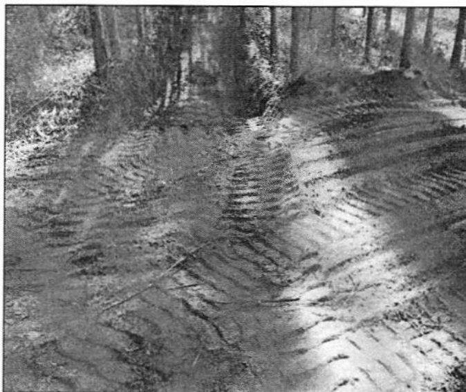
Foto 01: Construção de camaleões no carreador dos talhões 123 e 124.
