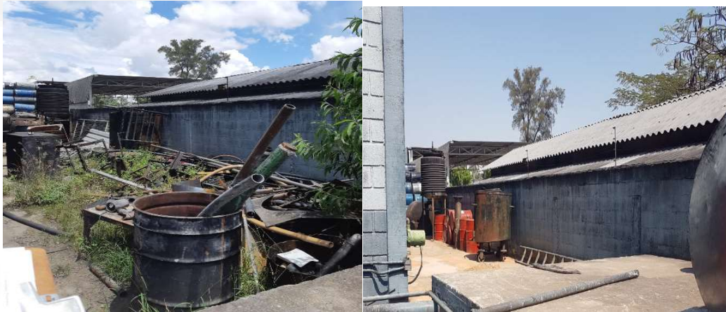
Figura 03: Antes e depois do local com entulho de sucatas.
