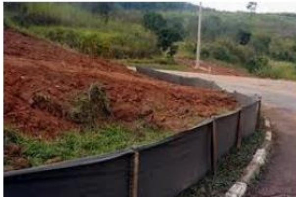
Figura 5-2 Barreira de Siltagem Geotextil
