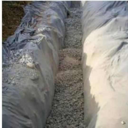
Figura 5-2 Barreira de Siltagem Geotextil
