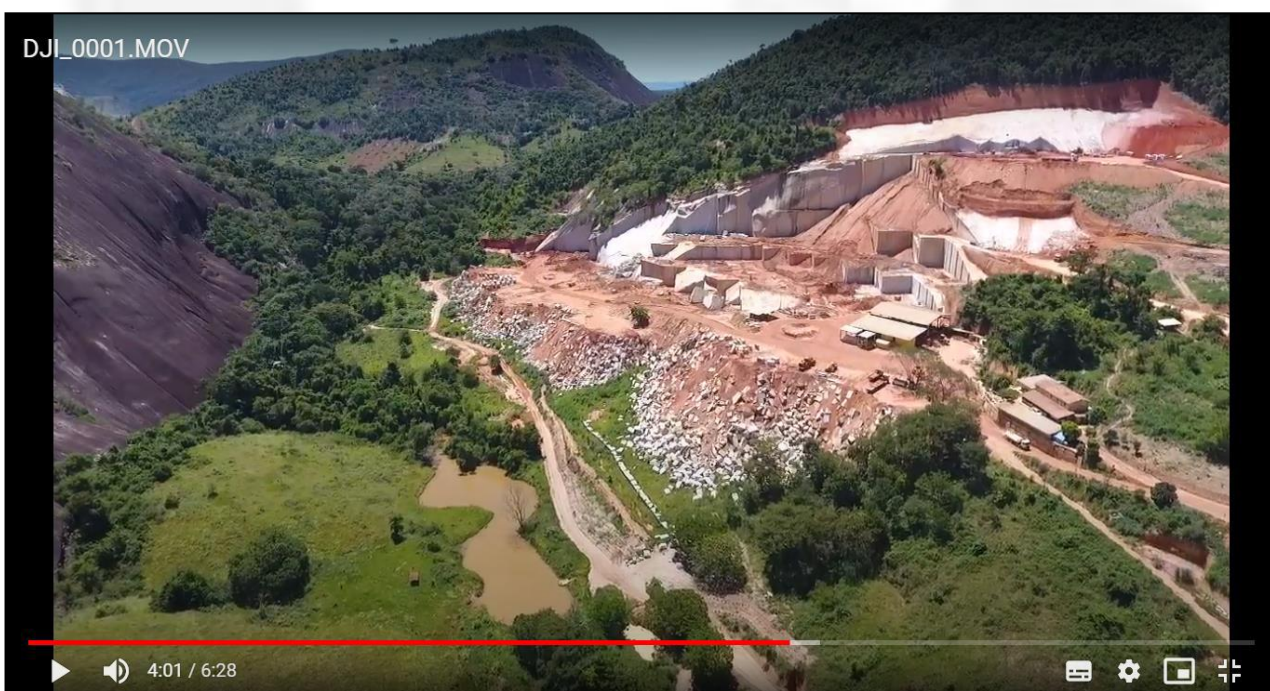
Foto 02. Vista geral do empreendimento de outro ângulo. Em primeiro plano, barramento em curso d'água.
