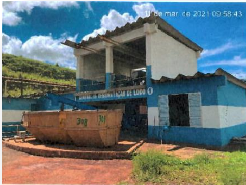
Figura 9: Central de desidratação de lodo.
