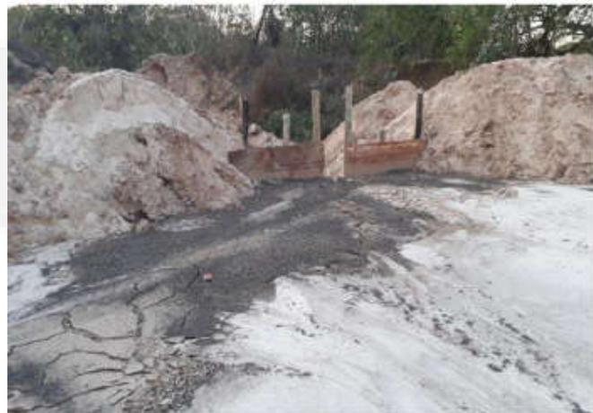
Foto 2. Caixa de areia e de contenção de sólidos para decantação dos efluente.
