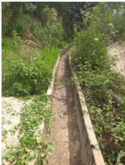
Foto 3. Canaleta impermeabilizada para escoamento do efluente líquido para o rio
