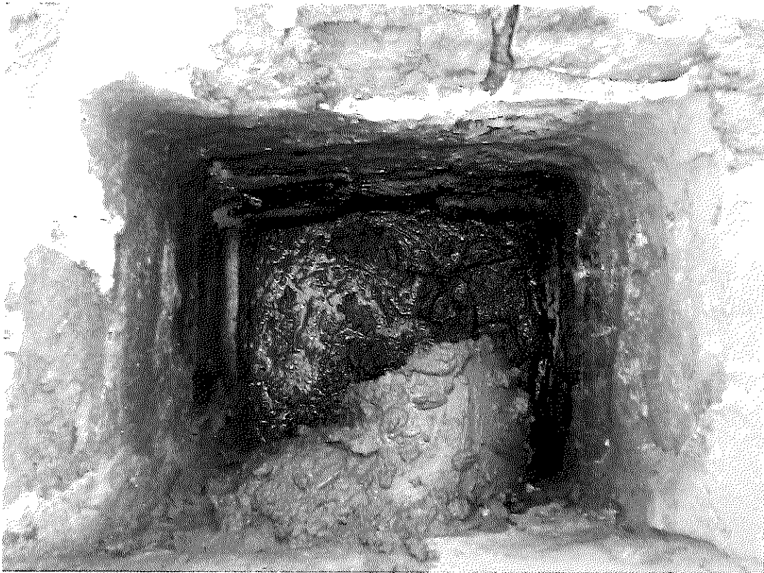
Figura 1 – Tamponamento saída efluente – Fonte: Moura 2015.
