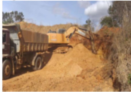
Carregamento de seixo rolado por escavadeira hidráulica.
