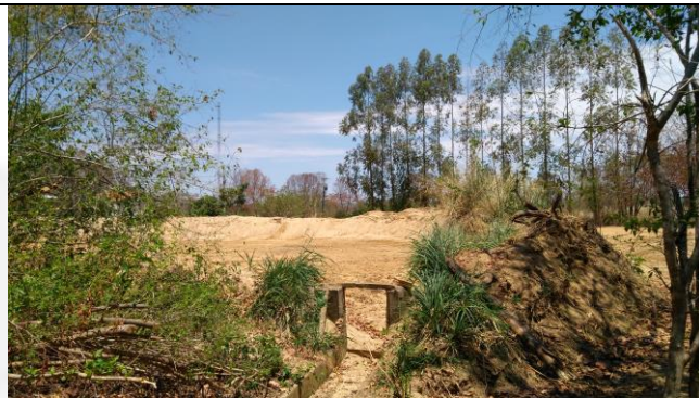
Foto 2. Caixa de depósito de areia
