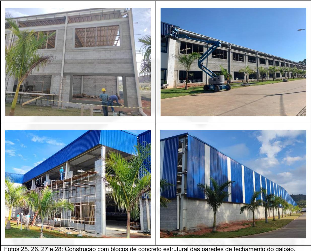
Fotos 25, 26, 27 e 28: Construção com blocos de concreto estrutural das paredes de fechamento do galpão.
