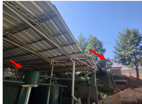
Foto 30: Gradeamento e equalizador
