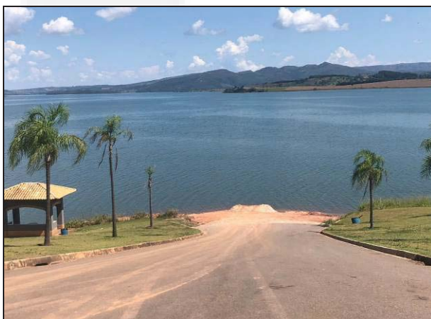
FOTO 3 – Rampa de acesso ao empreendimento.
