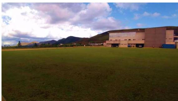
Figura 02 - Local de construção do galpão para armazenagem de insumos
