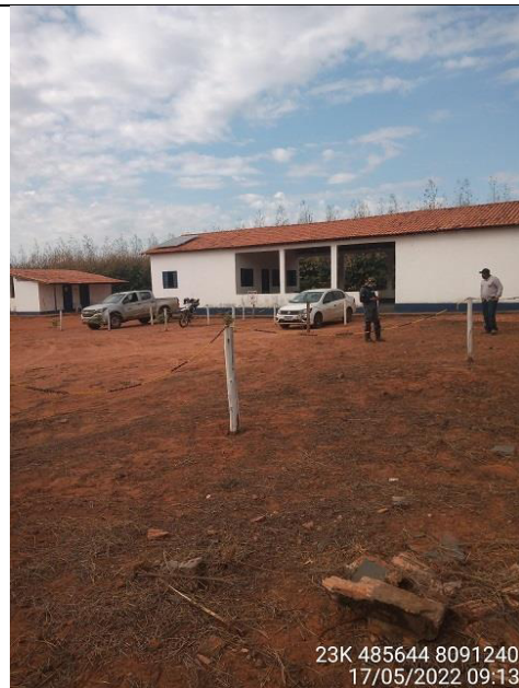
Edificações de apoio.
