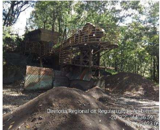
Foto 06. UTM para beneficiamento de minério.
