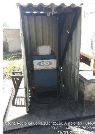
Foto 10. Área de abastecimento.
