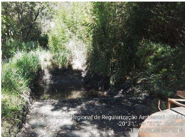
Foto 07. Cacimba para infiltração de efluentes pluviais.
