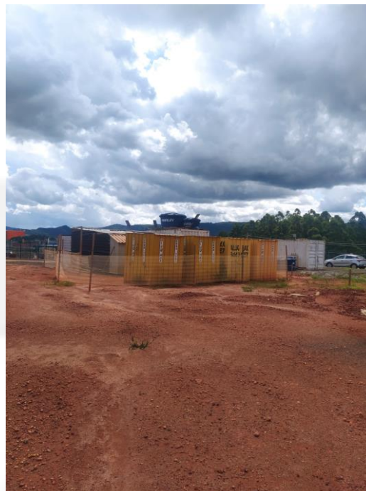
Foto 12: Canteiro de obras. Foto de 15/03/2023
