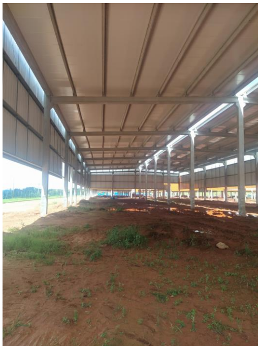
Foto 7: Galpão em instalação. Foto de 15/03/2023
