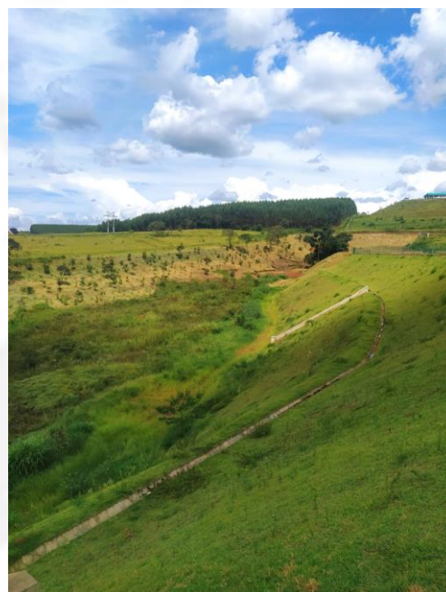
Foto 14: Área em recomposição, rede de drenagem e escada de dissipação. Foto de 15/03/2023
