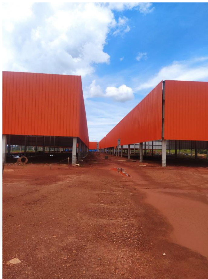
Figura 3: Foto dos galpões em instalação. Data: 15/03/2023
