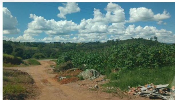
Foto 4: Resíduos de construção civil disposto inadequadamente (foto do dia 15/02/2017)
