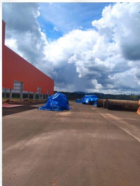
Foto 10: Galpão em instalação. Foto de 15/03/2023
