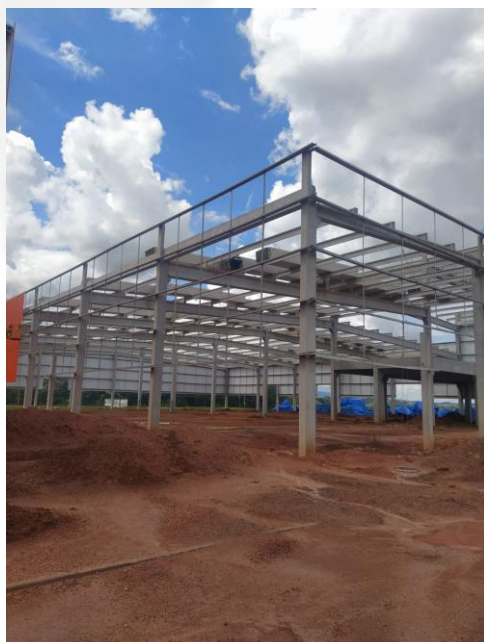
Foto 9: Galpão em instalação. Foto de 15/03/2023
