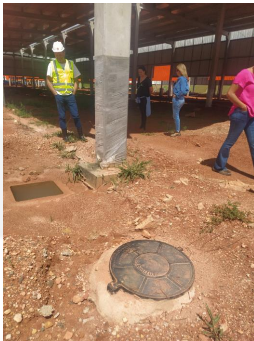
Foto 8: Galpão em instalação. Foto de 15/03/2023
