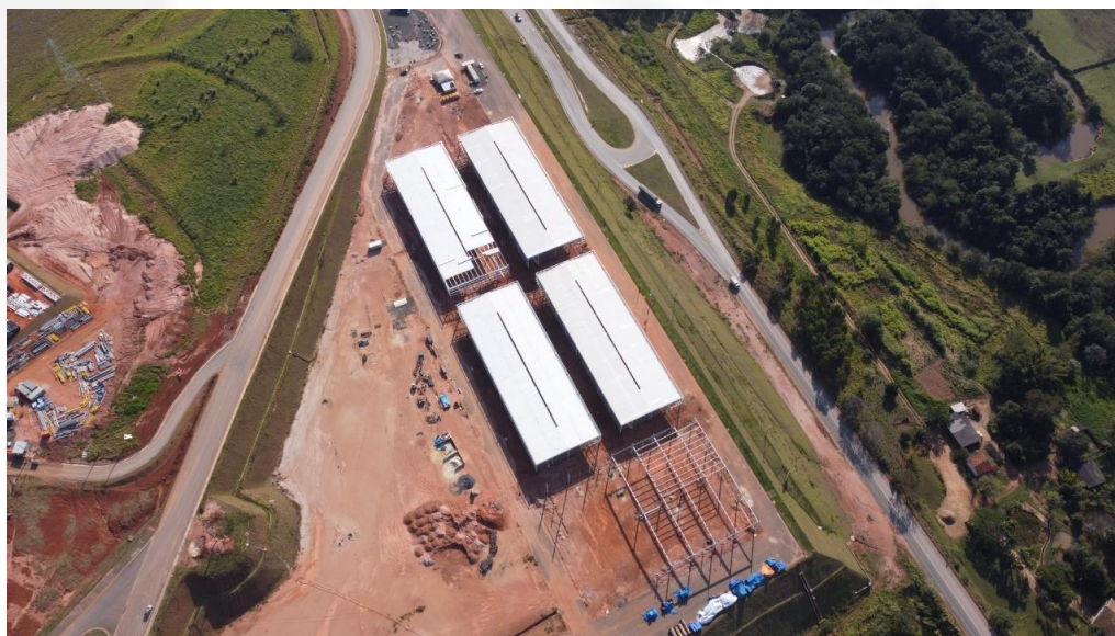
Figura 2: Foto aérea do empreendimento em instalação. Data: 07/06/2022
