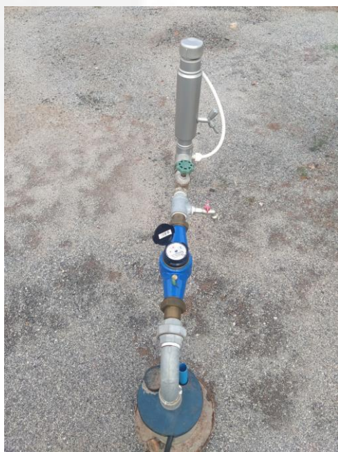
Foto 13: Poço tubular com hidrômetro a regularizar. Foto de 15/03/2023
