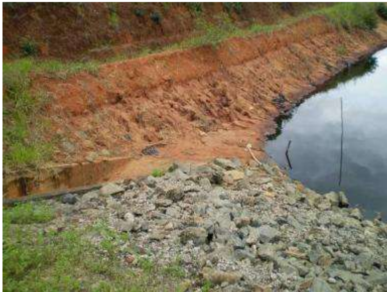
Vertedouro da Barragem A
