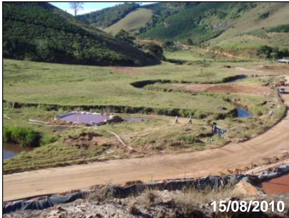
Bacias de deposição temporária do material
