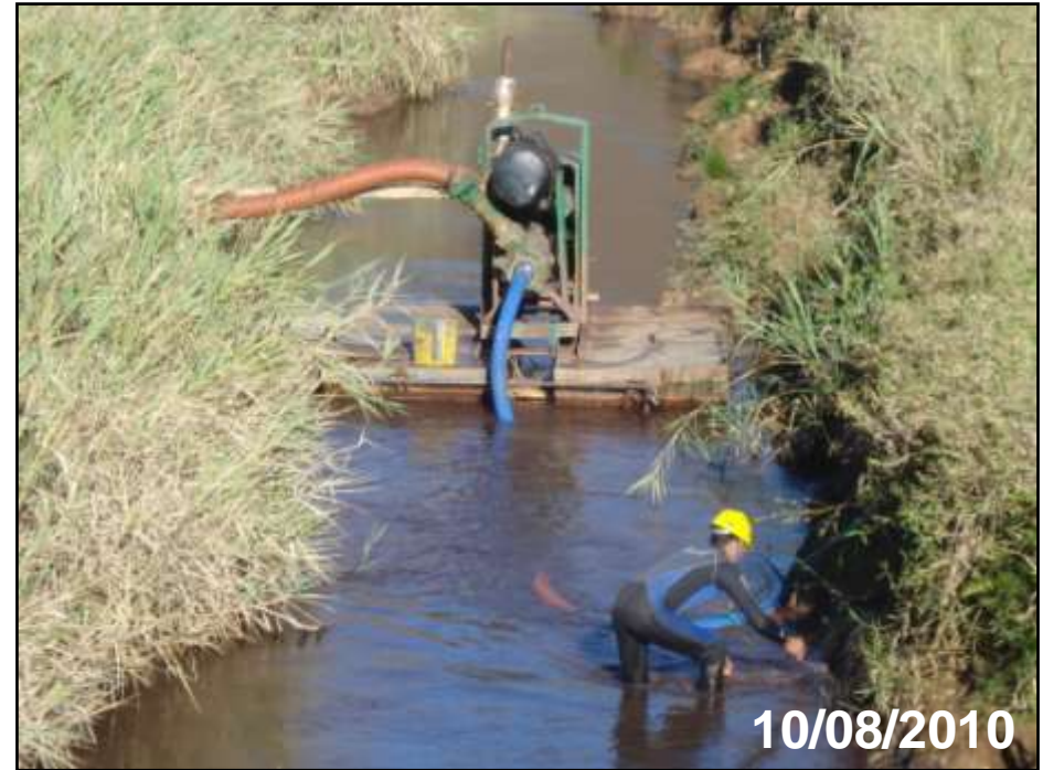
Bombas utilizadas na limpeza do rio
