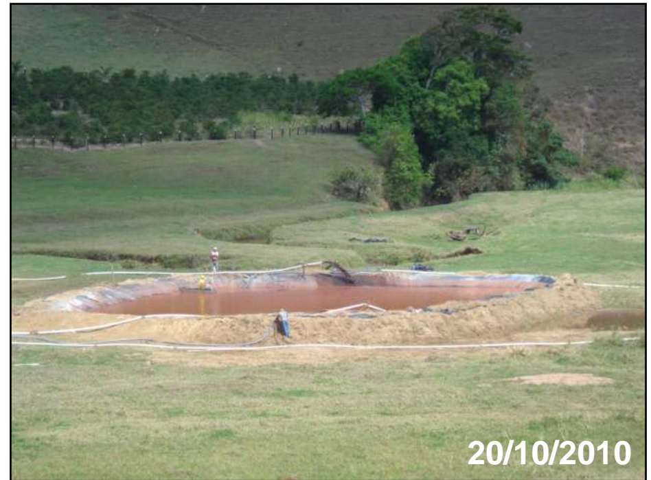
Bacias de deposição temporária do material
