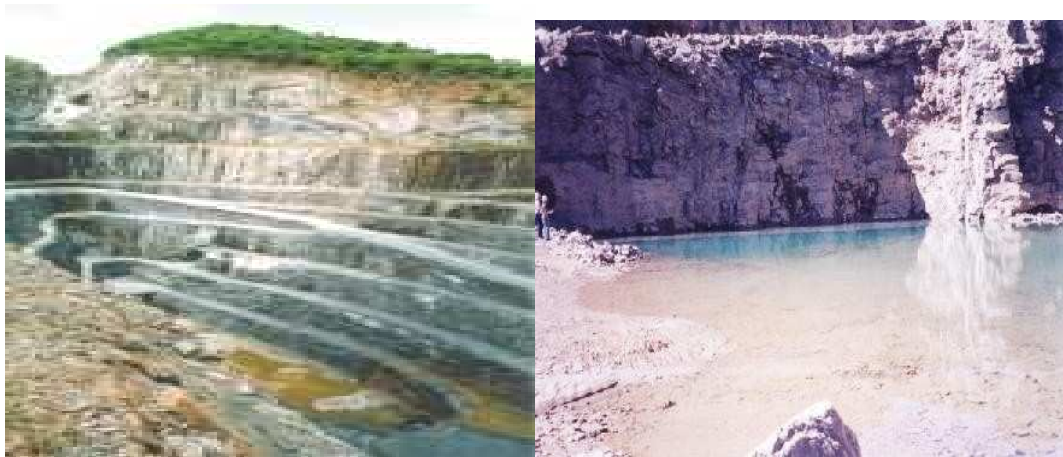
Figura 13 – Rebaixamento do nível de água
