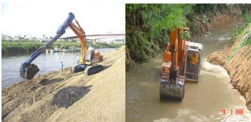
Figura 8 – Dragagem e desassoreamento de cursos de água
