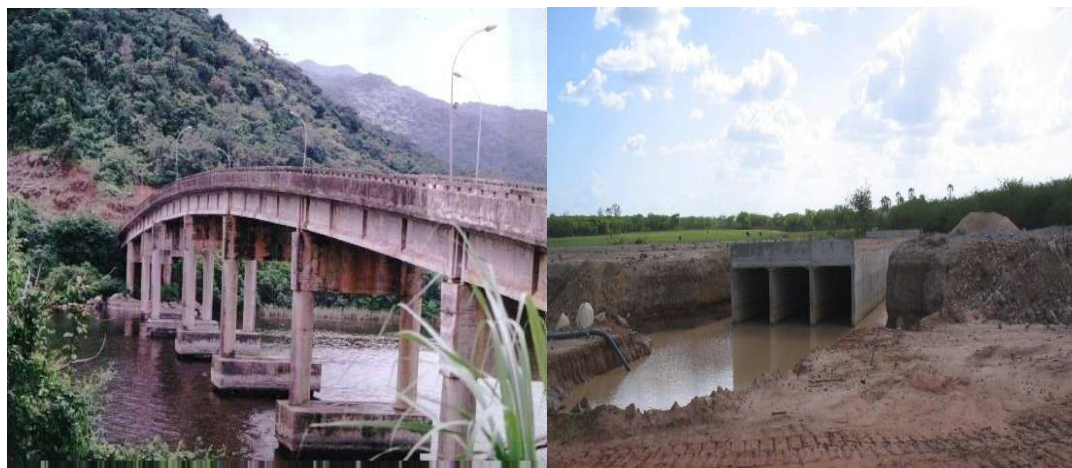
Figura 6 – Ponte e Bueiro Celular Triplo
