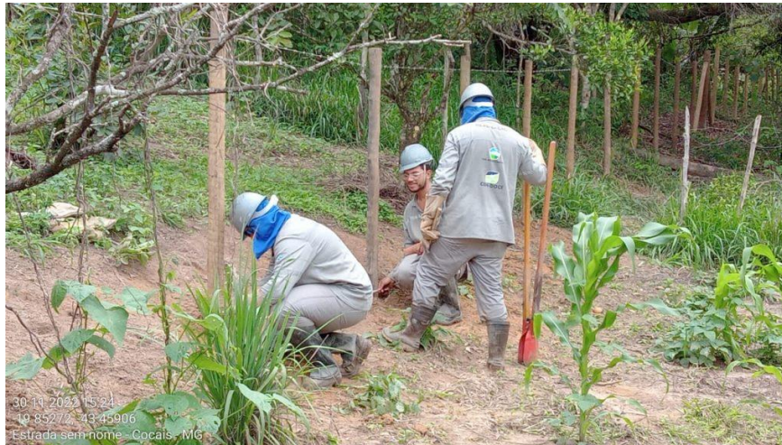
Figura 18 - Cercamento de nascentes na Bacia do Rio Piracicaba
