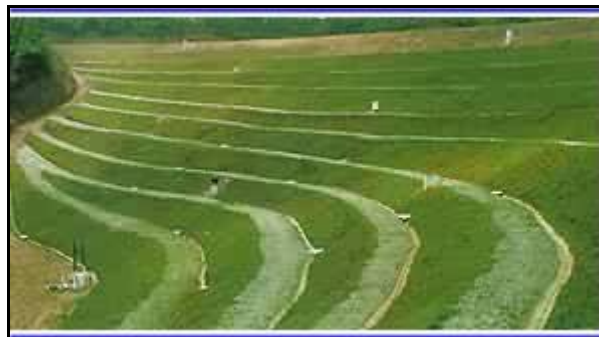
Figura 4.22: Aterro totalmente concluído.
