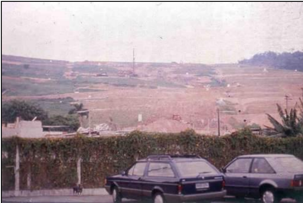
Figura 4.21: Aterro em estágio quase final de conclusão das atividades
