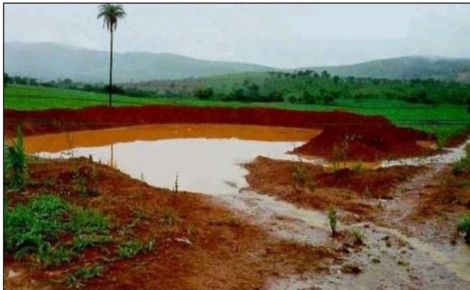
Figura 4.3: Bacia de contenção recebendo as águas de enxurrada em Sete Lagoas – MG. (EMBRAPA,1997)
