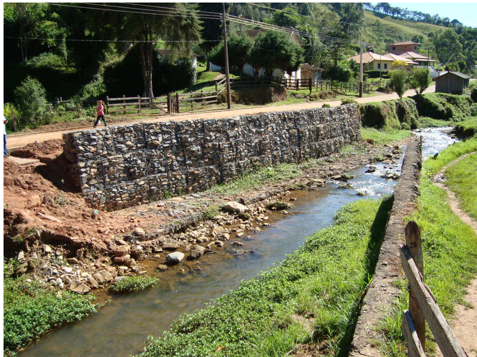
Ilustração 2: Vista parcial da contenção de talude no Ribeirão Sertão
