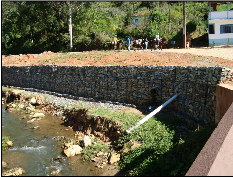
Ilustração 1: Vista parcial da contenção de talude no Ribeirão do Sertão
