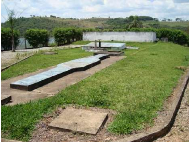
Figura 154 - Estação de tratamento de esgoto do povoado rural Ponte do Funil (Lavras).
