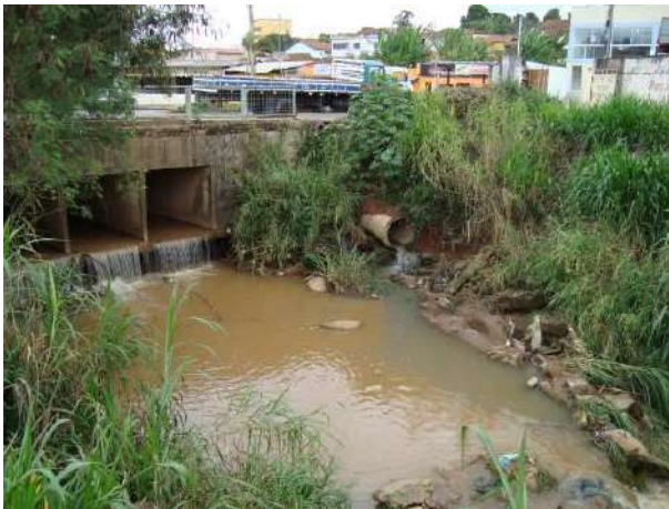
Figura 192 - Ponto de lançamento de efluentes domésticos e industriais da sede municipal de Oliveira.
