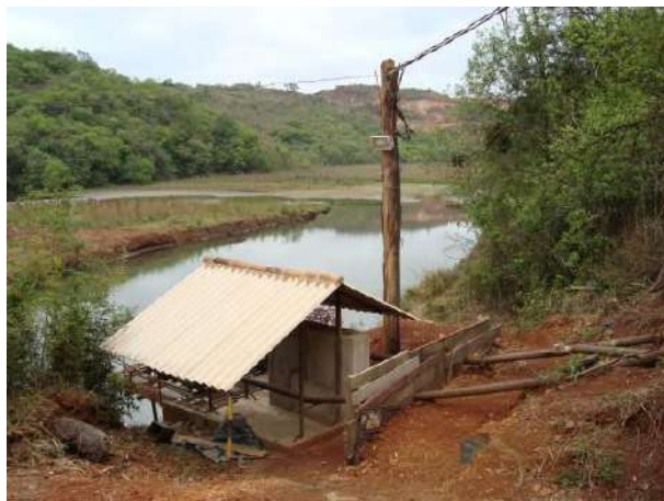
Figura 140 - Captação para o abastecimento industrial.
