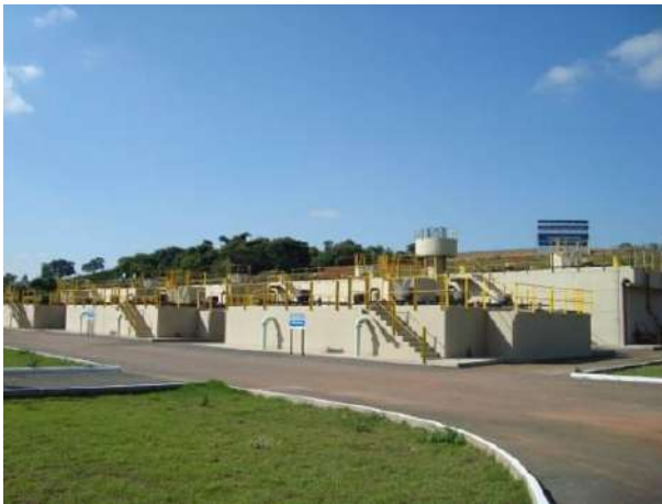
Figura 168 - Estação de tratamento de efluentes da sede municipal de Lavras.
