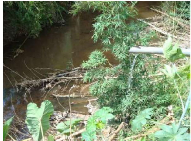
Figura 207 - Ponto de lançamento de efluentes domésticos do povoado rural Fagundes (Santo Antônio do Amparo).
