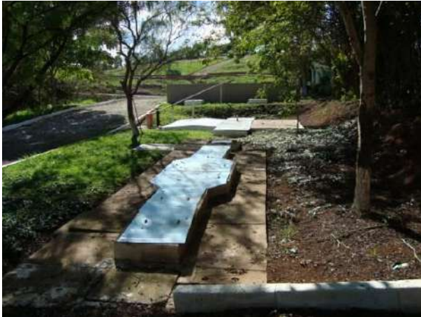
Figura 148 - Estação de tratamento de esgoto do distrito Macaia (Bom Sucesso).
