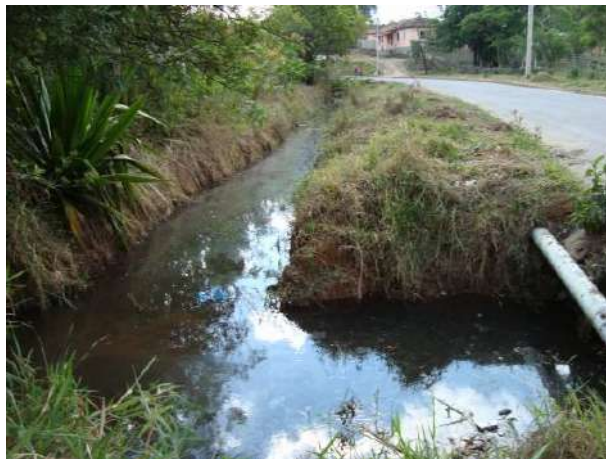
Figura 119 - Ponto de lançamento de efluentes domésticos e industriais provenientes da sede municipal de Ritápolis.
