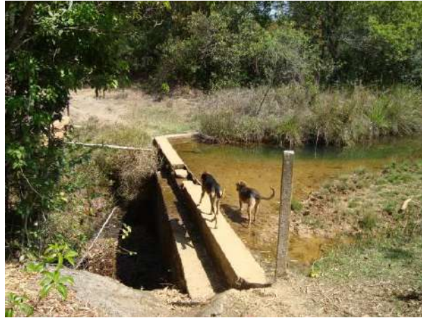
Figura 128 - Ponto de captação para o abastecimento doméstico do distrito de São Sebastião da Vitória.
