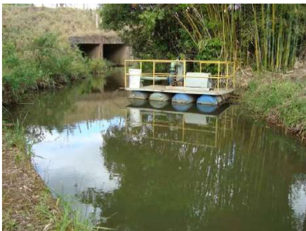
Figura 120 - Em destaque balsa de captação para abastecimento doméstico e industrial da sede municipal de Ritápolis.
