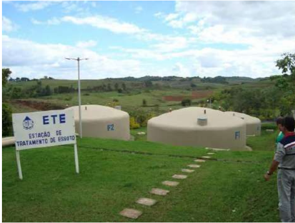
Figura 145 - Estação de tratamento de esgoto da sede municipal de Bom Sucesso.
