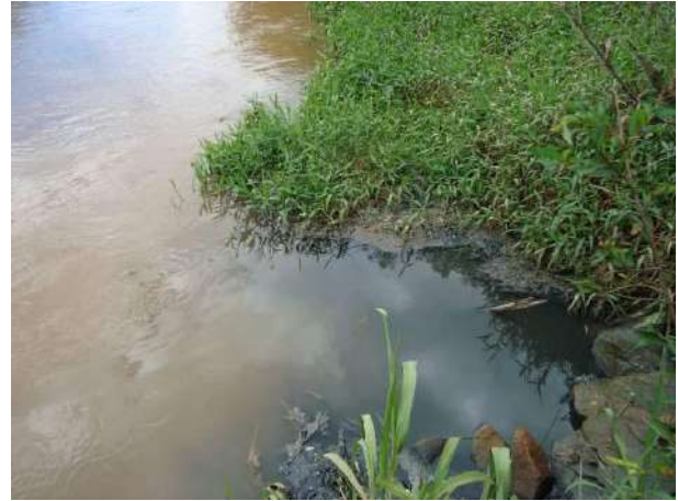
Figura 146 - Ponto de lançamento de efluentes tratados provenientes da estação de tratamento da sede municipal de Bom Sucesso.
