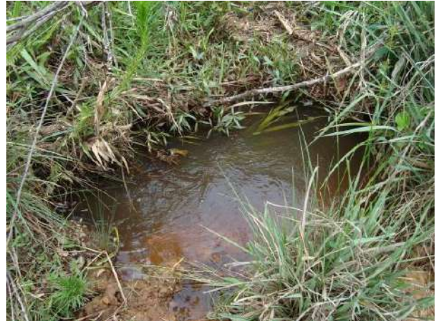
Figura 195 - Ponto de lançamento de efluentes tratados da comunidade rural Campos (Carmo da Mata).
