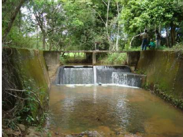
Figura 144 - Captação para o abastecimento doméstico e industrial da sede municipal de Bom Sucesso.
