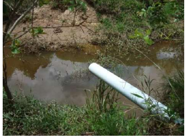
Figura 214 - Ponto de lançamento de efluentes tratados da sede municipal de Cana Verde.
